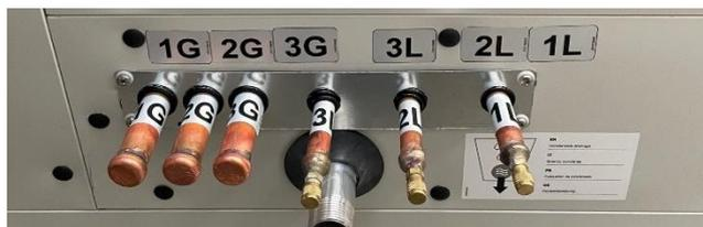
Quand les unités s-AIRME-G02/G07 sont associées à des Mr. Slim d'une capacité différente, les étiquettes des collecteurs de la batterie ED indiquent également la dimension de la Mr. Slim à laquelle ils doivent être connectés.
