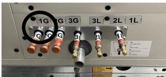
Pour protéger le panneau de l'unité s-AIRME-G02/G07 spécial de la sortie des collecteurs de la batterie à expansion directe, l'unité est dotée d'une tôle de protection.
