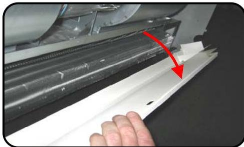
Le bord avant du bac de vidange est maintenant incliné vers le bas ce qui facilite le nettoyage du bac. Éliminer tous les débris et impuretés déposées sur la face du serpentin, le bac de vidange, le tuyau de sortie, les tuyaux et dispositif d'enlèvement des condensats.
