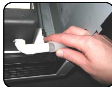
Si l'écoulement libre des condensats ne convient pas, l'installateur pourra envisager la pose d'une pompe (non fournie) pour évacuer les condensats directement de l'appareil. La pompe de relevage des condensats aura une capacité suffisante (voir Tableau ci-après), et (si elle est située au-dessus du bac de vidange) sera munie d'un amorçage automatique et sera capable
