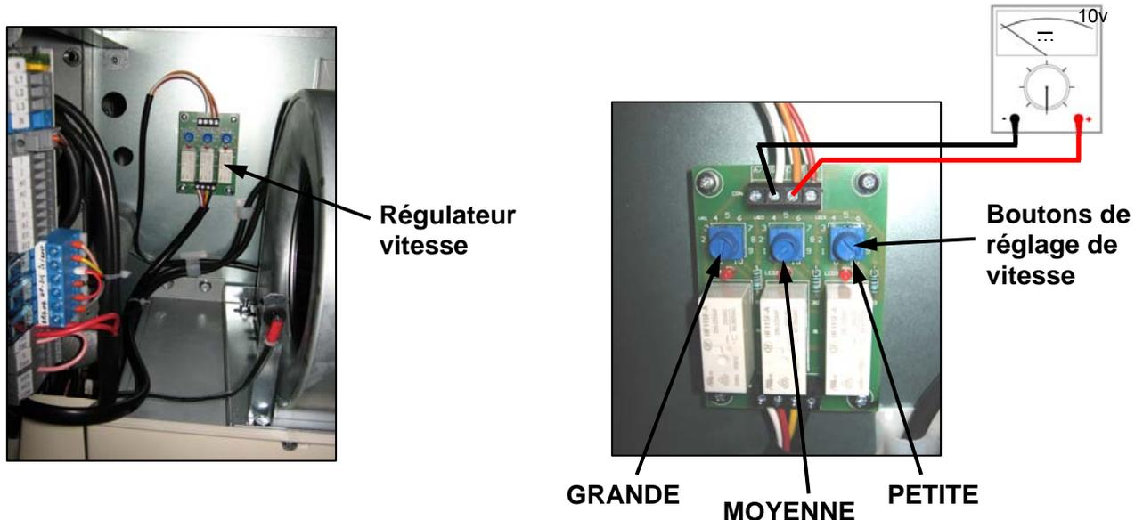
Les boutons de réglage de vitesse peuvent être ajustés entre 0 et 10 (grande), vérifier à l'aide d'un voltmètre pour régler à la bonne vitesse. Les 3 vitesses de ventilation sont pré-réglées en usine mais peuvent être recalibrées à la mise en place selon les besoins de l'installation, pour s'adapter aussi bien aux conditions environnementales internes qu'aux niveaux de bruit interne.
